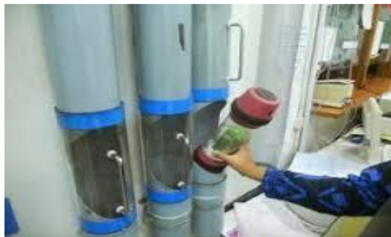
Gambar 5.19 kegiatan distribusi rekam medis menggunakan Pneumo tube
